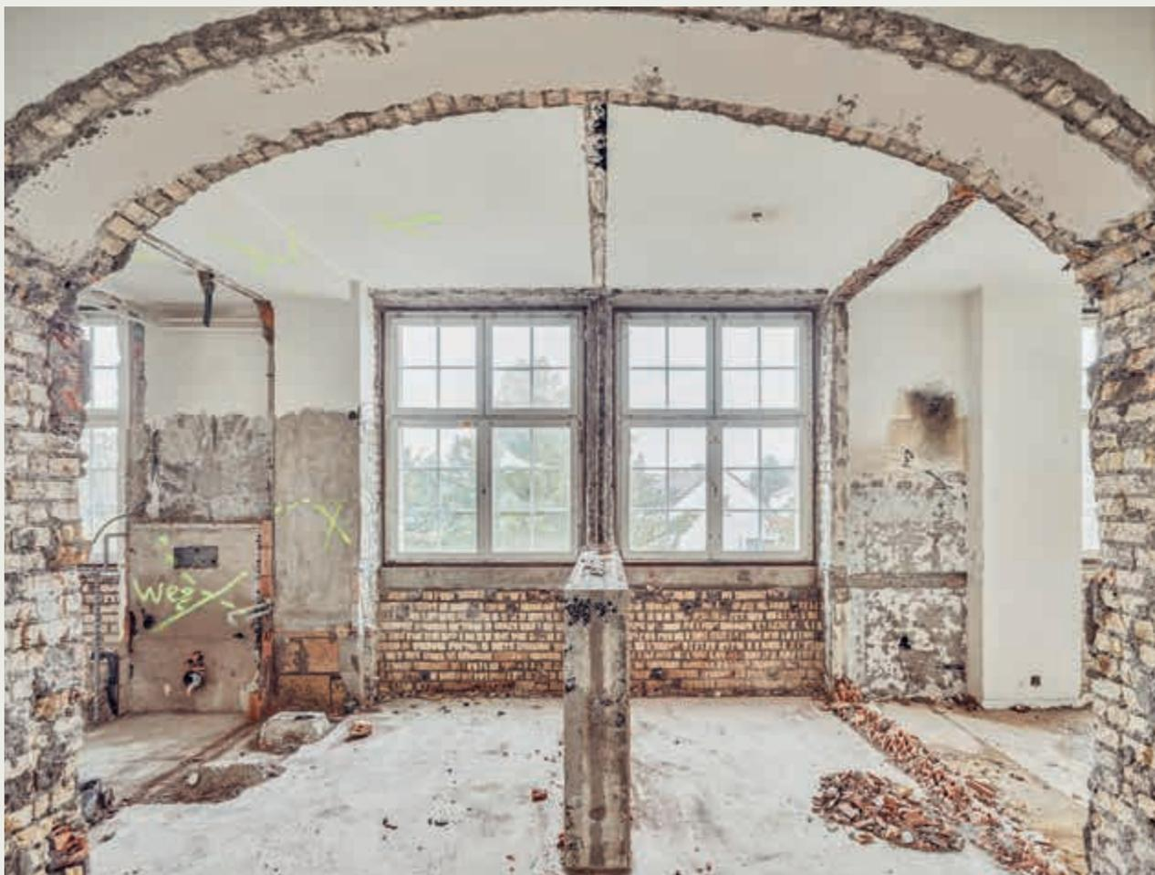
Das Mauerwerk musste besonders sorgfältig zurückgebaut werden, um wirklich alle Gipsreste zu entfernen.
