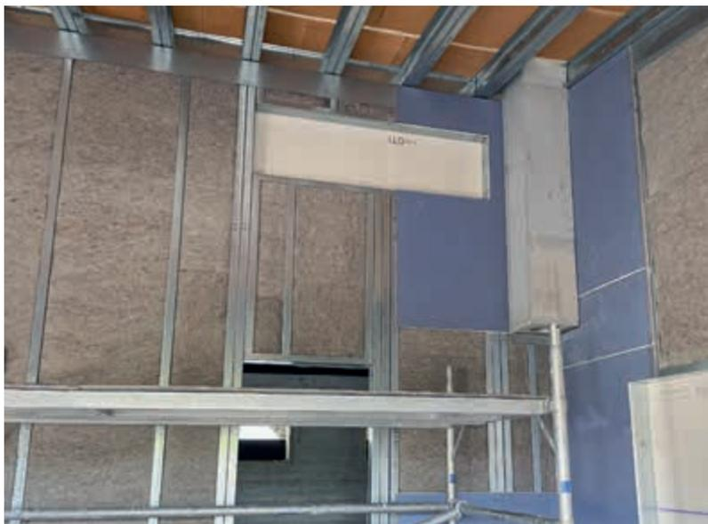
**Die tragenden C-Träger-Wandprofile sind mit natürlicher Schafwolle ausgefüllt und innenseitig mit aussteifenden Hartgipsplatten verkleidet.**
